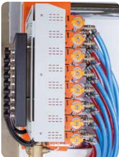
Regelversion mit automatischer Durchflussmengenregelung
