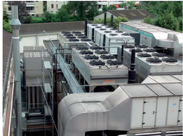
Die Energie sparende hermeticool Kühlanlage in Zweikreis-Ausführung verzichtet bei niedrigen Außentemperaturen komplett auf den kostenintensiven Einsatz von Kältekompressoren.
